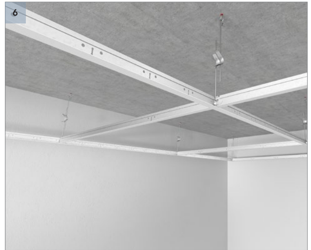
Anschließend werden die 1.200 mm langen T24-Klick-Querschienen mit einem Achsabstand von 1.200 mm montiert.
